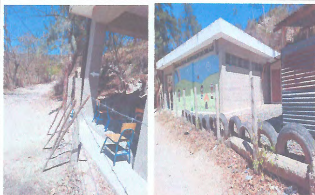
Foto 3: MEJORAMIENTO DE MURO PERIMETRAL
