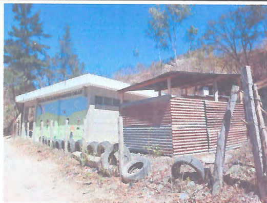
Foto 1: MEJORAMIENTO DE ESTRUCTURA DE COCINA
